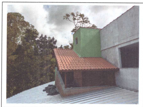
INSTALAÇÃO DAS TELHAS
