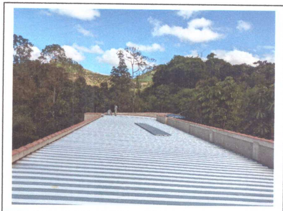
INSTALAÇÃO DAS TELHAS
