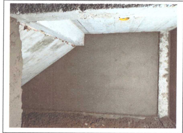
EXECUÇÃO DE EMBOÇO
