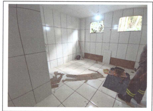
ASSEMENTO REVESTIMENTO DE PAREDE
