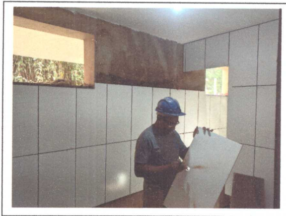
ASSEMENTO DE REVESTIMENTO DE PAREDE
