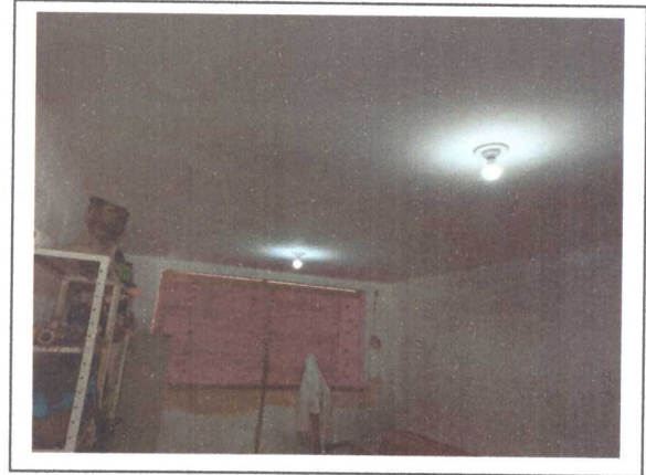
INSTALAÇÃO DE PLAFONIER
