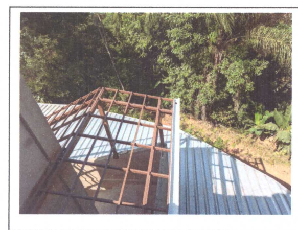
MONTAGEM DE ESTRUTURA DO TELHADO
