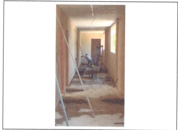
EXECUÇÃO DE CONTRAPISO
