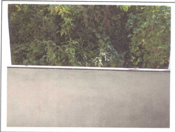
ASSENTAMENTO DE PEITORIL
