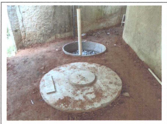
EXECUÇÃO DE FOSSA SÉPTICA
