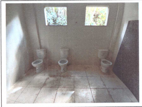
INSTALAÇÃO DE VASO SANITÁRIO
