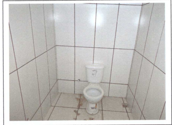
INSTALAÇÃO DE VASO SANITÁRIO
