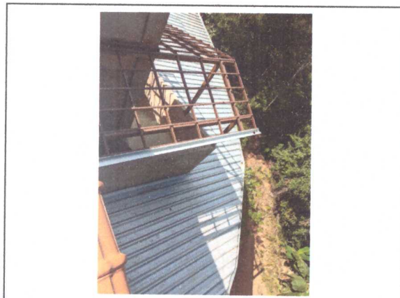
INSTALAÇÃO DAS TELHAS
