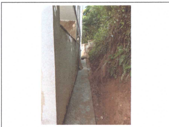
RECUPERAÇÃO DE CALÇADA
