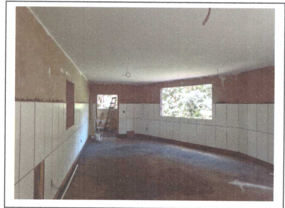
ASSEMENTO DE REVESTIMENTO DE PAREDE
