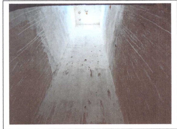
PINTURA DO POÇO DE ELAVADOR
