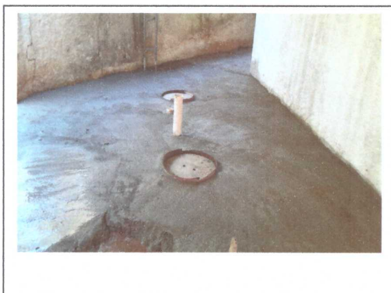
NIVELAMENTO DO PISO DO PÁTIO
