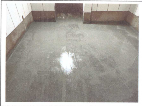
EXECUÇÃO DE PISO DE GRANITINA
