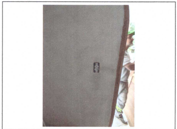
INSTALAÇÃO DE INTERRUPTOR
