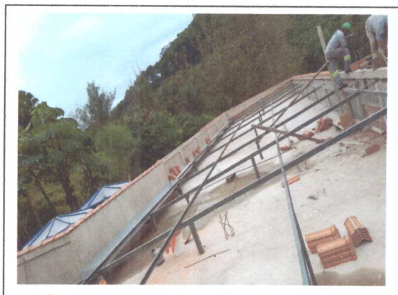
INSTALAÇÃO DE PINGADEIRA
