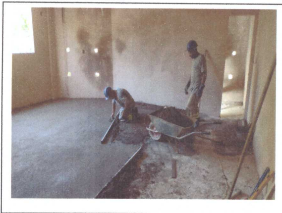
EXECUÇÃO DE CONTRAPISO
