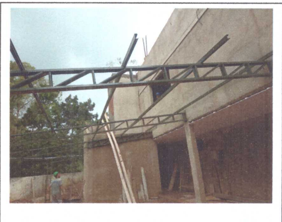
MONTAGEM DE ESTRUTURA DO TELHADO
