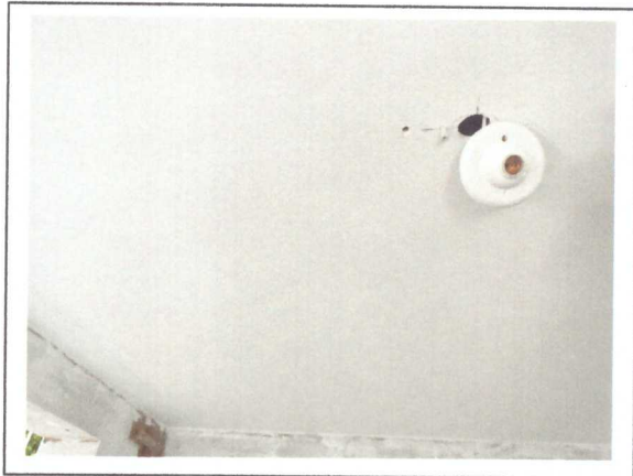
INSTALAÇÃO DE PLAFONIER
