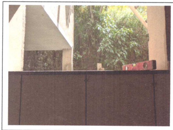
ASSENTAMENTO DE PEITORIL
