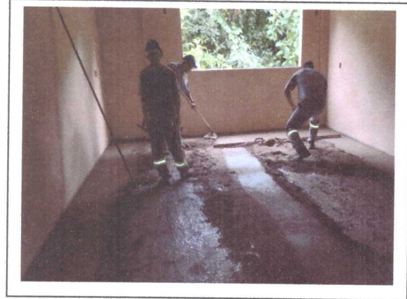
EXECUÇÃO DE CONTRAPISO
