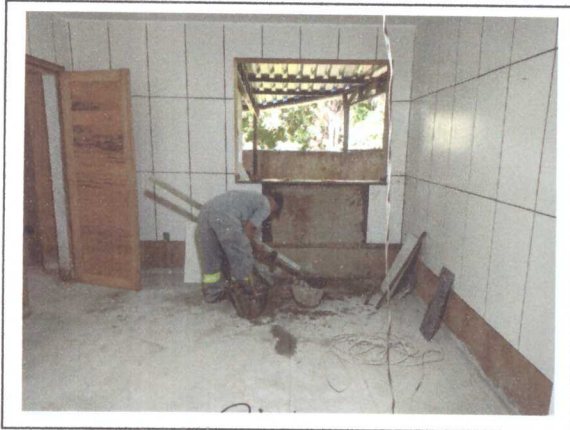
ASSEMENTO DE REVESTIMENTO DE PAREDE
