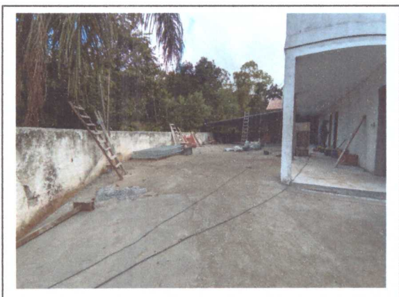
NIVELAMENTO DO PISO DO PÁTIO
