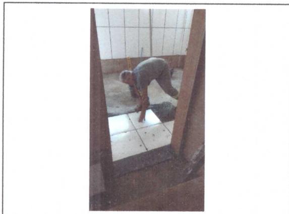
ASSENTAMENTO DE PISO
