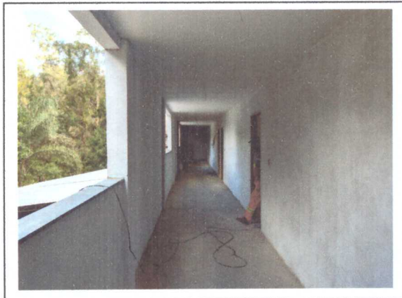
PINTURA COM SELADOR
