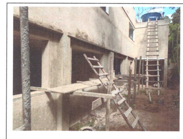
EXECUÇÃO DE REBOCO
