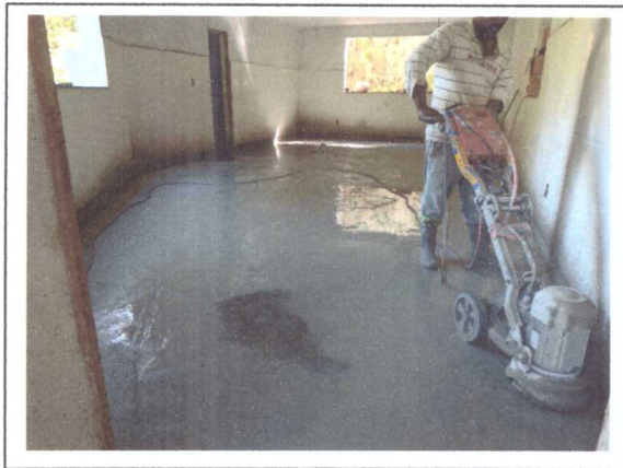
EXECUÇÃO DE PISO DE GRANITINA
