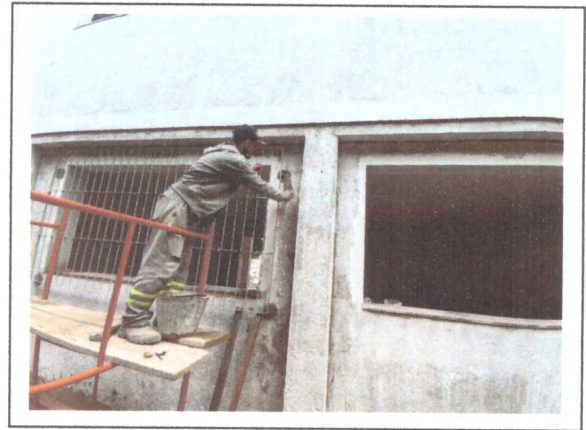
INSTALAÇÃO DE GRADE DE PROTEÇÃO DE JANELAS
