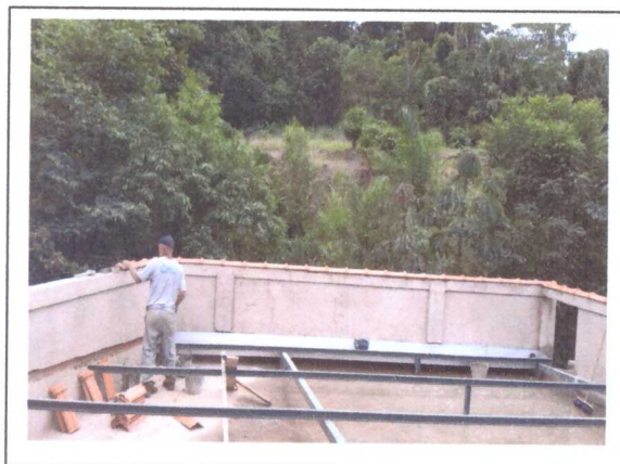
INSTALAÇÃO DE PINGADEIRA
