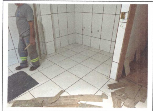
ASSENTAMENTO DE PISO
