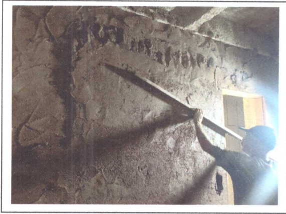
EXECUÇÃO DE EMBOÇO
