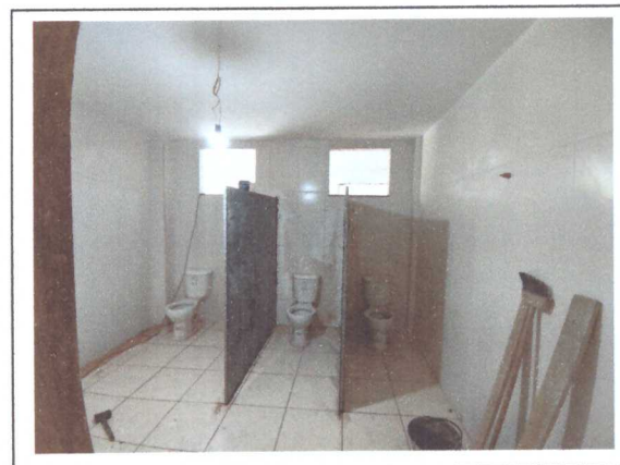
ASSENTAMENTO DA DIVISÓRIA DE GRANITO
