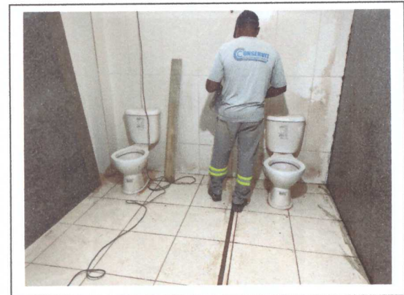
ASSENTAMENTO DA DIVISÓRIA DE GRANITO
