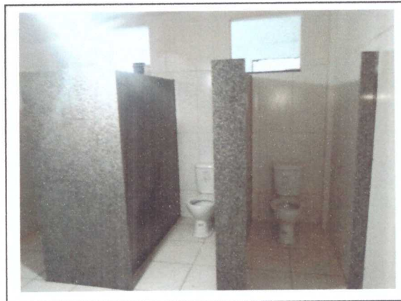
ASSENTAMENTO DA DIVISÓRIA DE GRANITO
