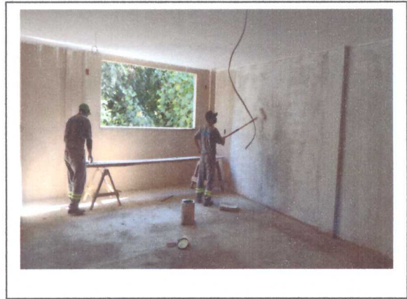
PINTURA COM SELADOR
