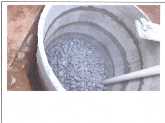
EXECUÇÃO DE FOSSA SÉPTICA
