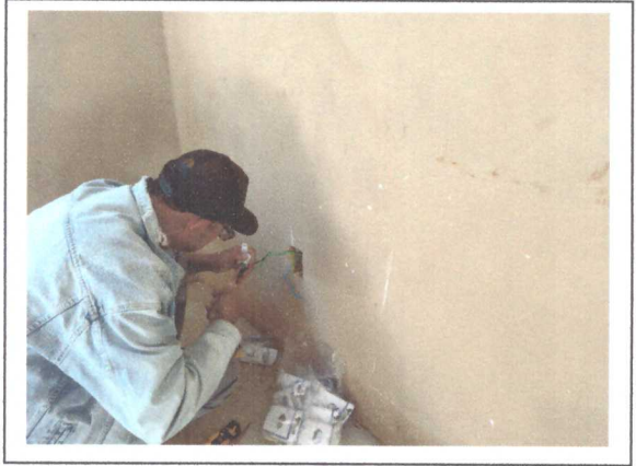
INSTALAÇÃO DE TOMADA
