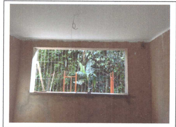
INSTALAÇÃO DE GRADE DE PROTEÇÃO DE JANELAS
