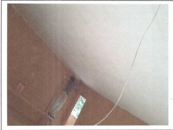
EMASSAMENTO DO TETO
