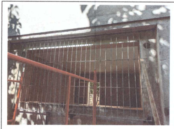
INSTALAÇÃO DE GRADE DE PROTEÇÃO DE JANELAS
