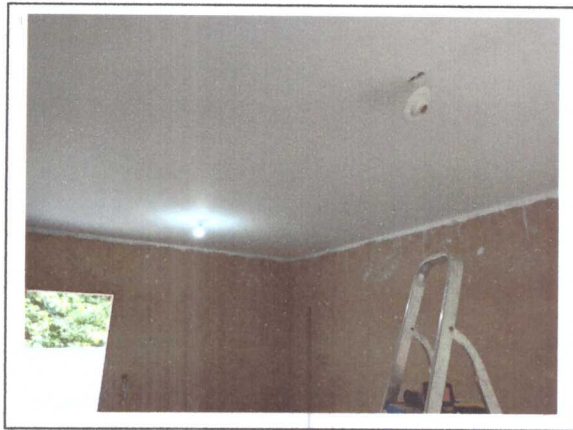
INSTALAÇÃO DE PLAFONIER
