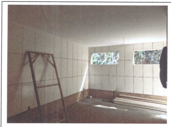
ASSEMENTO DE REVESTIMENTO DE PAREDE
